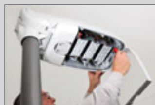
3. Verbindungsschrauben des Geräteträgers lösen.
