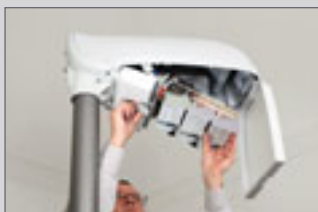
4. Drehriegel öffnen, Geräteträger herabklappen.
