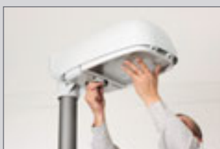
1. Leuchte öffnen: Ein Drehriegel sichert die Leuchtenabdeckung.
