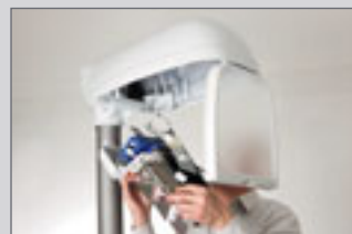
6. Geräteträger aushängen und durch Geräteträger mit neuer LED-Generation ersetzen.
