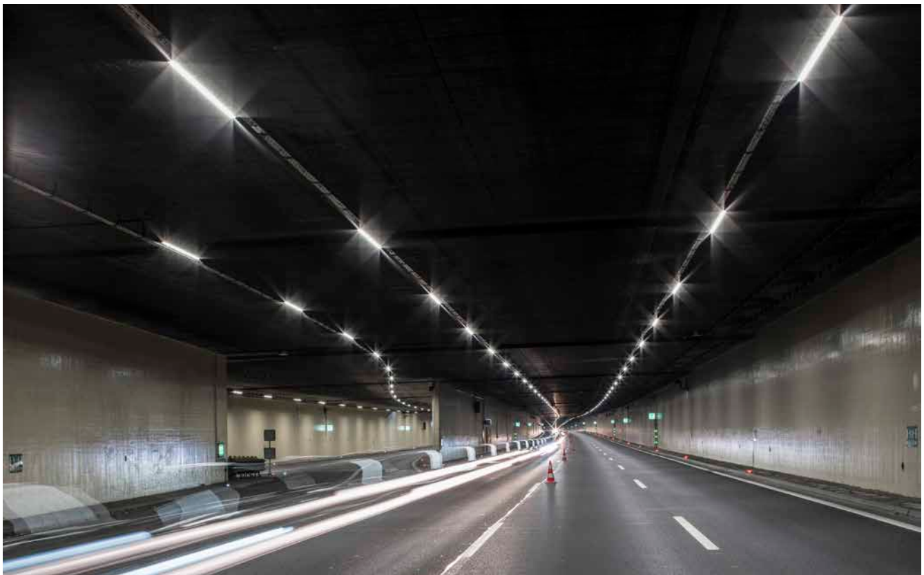
Projekt: Kaisermühlentunnel, Wien, Österreich
